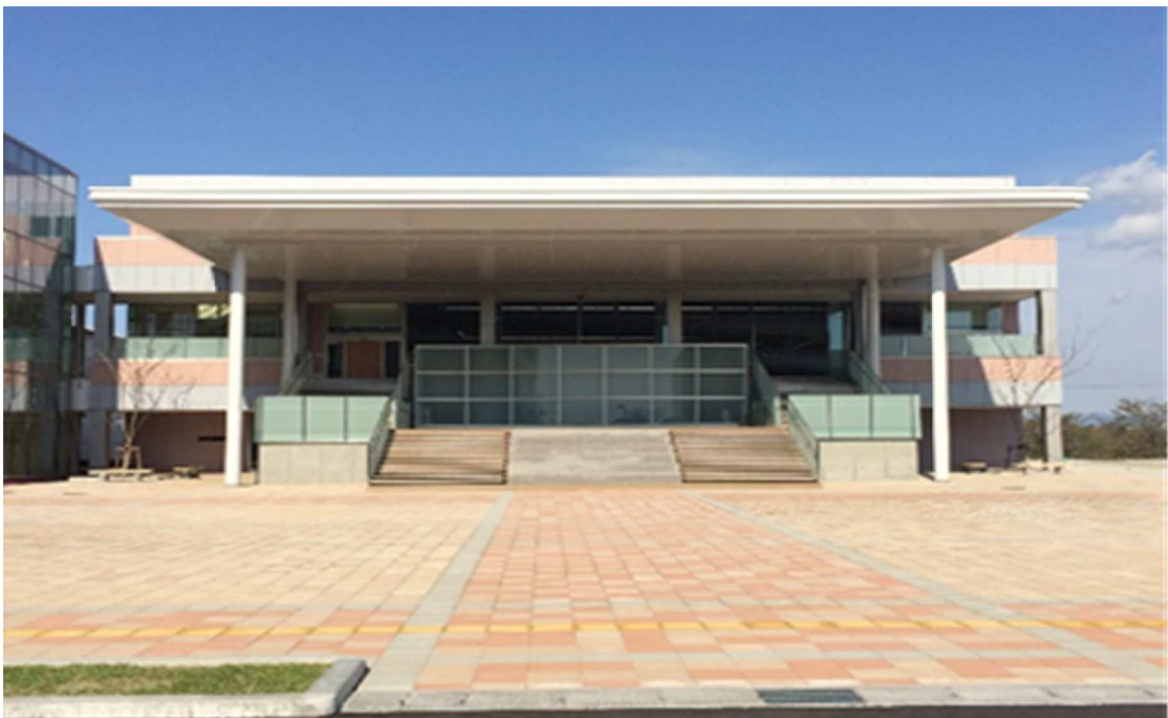
【第9研究・実習棟外観】
