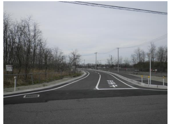
【第8駐車場乗入口付近】
