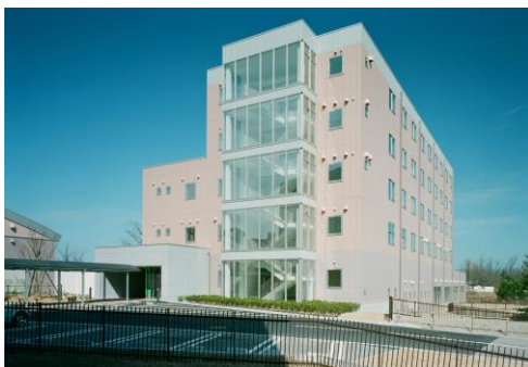
<第7研究・実習棟の外観>
